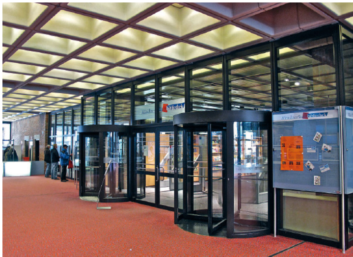
Abb. 6. Eingang zur Stadtbibliothek in Gasteig. Quelle: Schlaier, CC BY-SA 3.0
