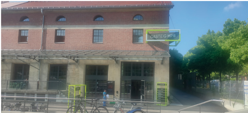
Abb. 10. Außenansicht des Gasteig HP8
